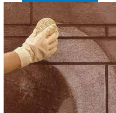
Limpieza y terminación de las juntas con esponja
