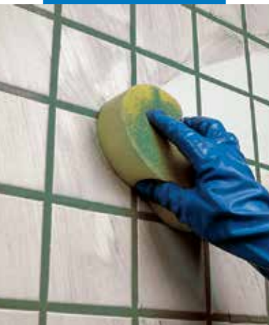
Limpieza y terminación de las juntas en pared con esponja
