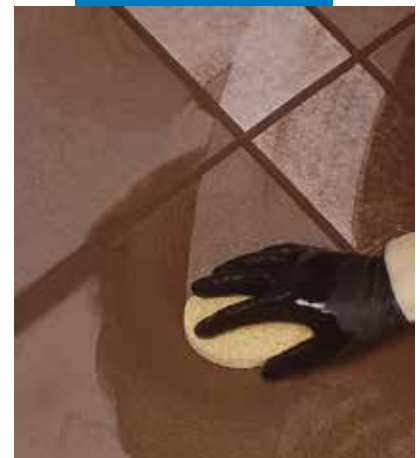
Limpeza y acabado de las juntas con esponja
