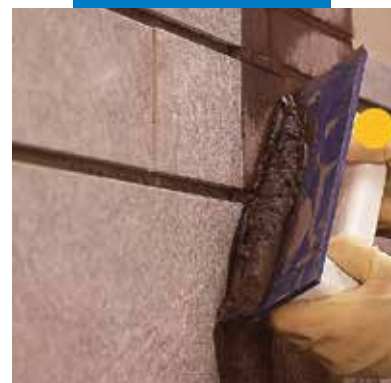
Ejemplo de relleno de juntas con Ultracolor Plus en piscina
